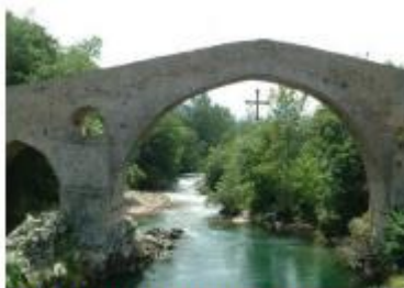
Puente romano con arco
